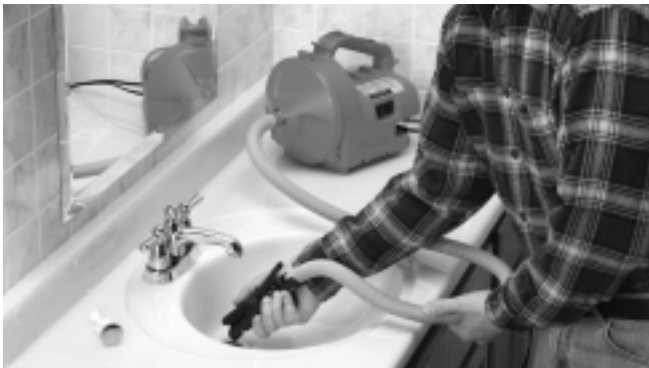
Figura 7 – Alimentación del cable dentro del desagüe
