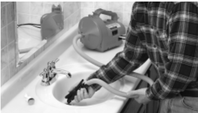
Figure 7 – Avancement du câble dans la canalisation
