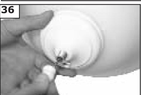
Aligner le trou dans le verre avec le trou de l'embout du fleuron afin de pouvoir y passer la chaînette de commande de la vitesse du ventilateur. Installer l'écrou fleuron et serrer.
