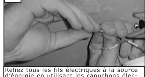
Reliez tous les fils électriques à la source d'énergie en utilisant les capuchons électriques fournis à cet effet. Assurez-vous qu'aucun filament ne dépasse des capuchons électriques. Après avoir établi les liaisons électriques, vous devez étaler les fils en mettant le conducteur mis à la masse et le conducteur de mise à la terre de l'appareillage d'un côté du boîtier de sortie de courant et le conducteur non mis à la terre de l'autre côté de la boîte de sortie de courant.
