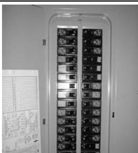
Avant de procéder à l'installation du ventilateur, coupez le courant au niveau du panneau d'entrée d'électricité et verrouillez le dispositif de sectionnement pour éviter que le courant ne soit branché accidentellement. Si vous ne parvenez pas à verrouiller le dispositif de sectionnement, placez sur le panneau d'entrée d'électricité une pancarte ou une étiquette de mise en garde bien visible.
