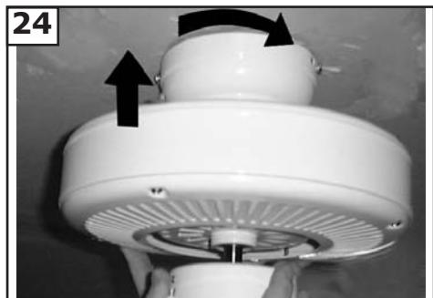
Prenez le support de suspension, et alignez les trous en forme de « L » avec les vis situées sur le support de suspension. Faites pivoter le support dans le sens des aiguilles d'une montre pour le mettre en position bloquée. Remettre en place les vis que vous avez retirées à l'étape précédente et serrez à fond. Installer les deux (2) autres vis fournies dans le paquet de quincaillerie et serrez à fond les quatre (4) vis.
