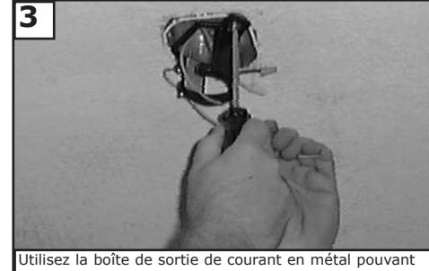
Utilisez la boîte de sortie de courant en métal pouvant supporter le poids du ventilateur (15,8 kg). Avant de relier le ventilateur à la boîte de sortie de courant, assurez-vous que celle-ci est parfaitement attachée au moins en deux points à une pièce de charpente du plafond (une boîte de sortie de courant mal attachée provoquera des secousses du ventilateur). Utilisez uniquement les vis fournies avec le boîtier de sortie de courant.
